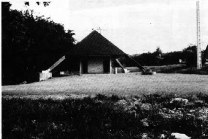
Paradero de La Forêt: las instalaciones sanitarias donde tuvo lugar la visión.
